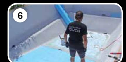
6 Boden stumpf oder überlappend verlegen.
