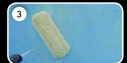
3 RENOLIT ALKORGLUE Kontaktkleber vollflächig auftragen.
