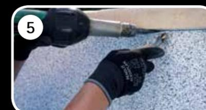
5 Wände mit RENOLIT ALKORPLAN TOUCH auskleiden.
