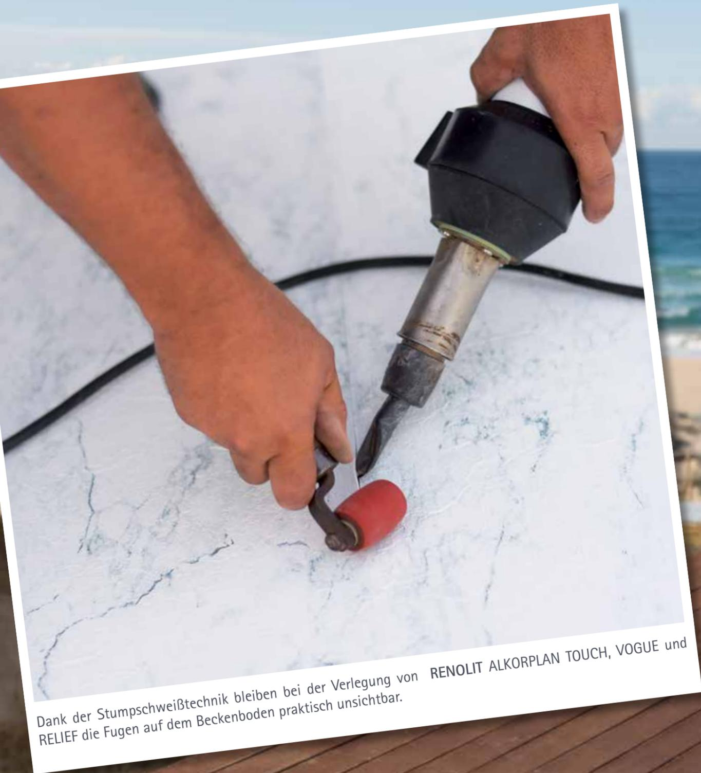
Dank der Stumpfschweißtechnik bleiben bei der Verlegung von **RENOLIT ALKORPLAN TOUCH, VOGUE** und **RELIEF** die Fugen auf dem Beckenboden praktisch unsichtbar.
